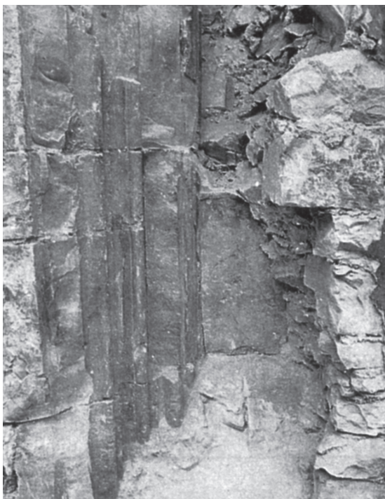
Saský dům, Relikty oken nalezených při opravě domu v roce 1964
