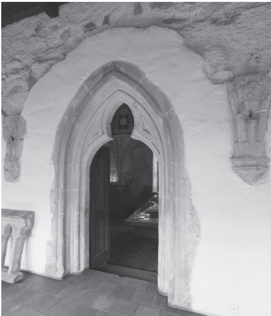
Obr. 4. Písek, vstupní portál vedoucí do menšího sálu.
