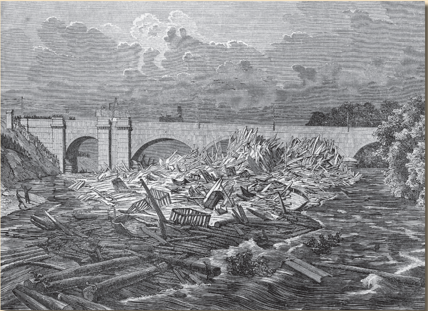
3 | Negrelliho viadukt při povodni roku 1872, Historický ústav AV ČR Oblouky Negrelliho viaduktu, spojujícího břehy Holešovic a Karlína, byly při povodni roku 1872 zataraseny naplaveným dřevem a nejrůznějšími předměty, které voda přinášela. Stejně tak se podle dobových fotografií hromadilo naplavené dřevo u Karlova mostu. Povodeň 25. a 26. května 1872 způsobily bouřky s extrémními srážkami, které zasáhly západní a střední Čechy.
